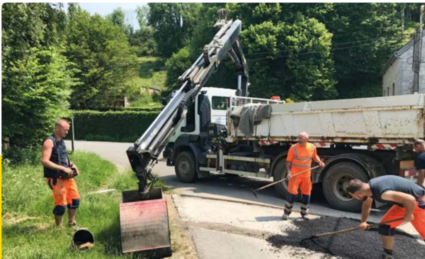
Travaux d'asphaltage par les ouvriers communaux
